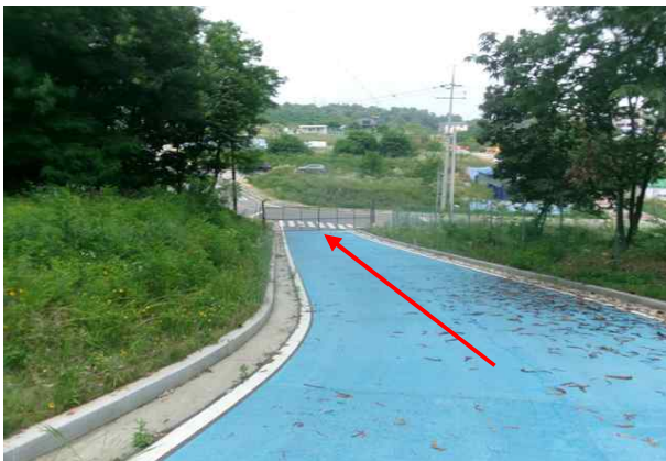
위 치 송수관로 (Sta.14+15.8) 손상내용 포장 및 지반 상태양호
