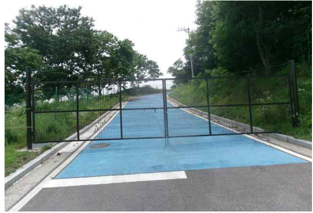
송수관로 중점부 전경
