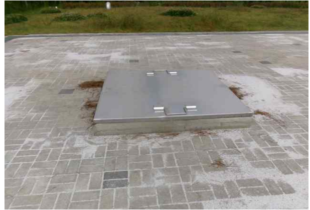
환기구 등의 덮개(장비 반입구) 현황
