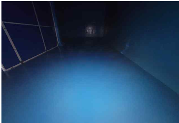
손상내용 2지 바닥슬래브 상태양호 손상원인 -
