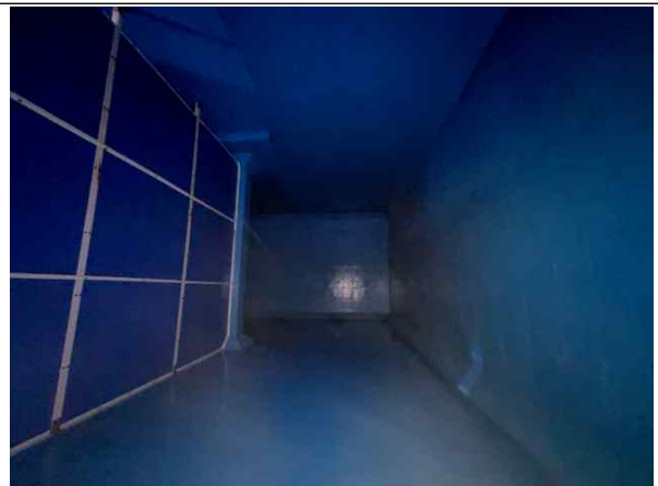
배수지 2지 내부 전경
