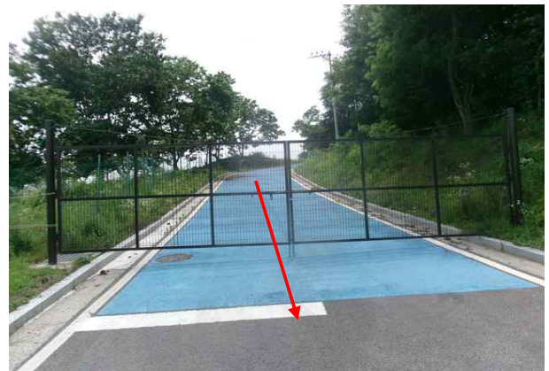
위 치 송수관로 (Sta.17+1.5) 손상내용 포장 및 지반 상태양호
