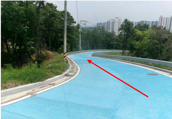
위 치 송수관로 (Sta.4+0.0) 손상내용 포장 및 지반 상태양호
