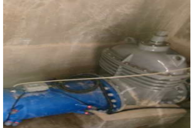
위 치 송수관로 Sta.4+0.0(유량계실) 손상내용 기초 상태양호
