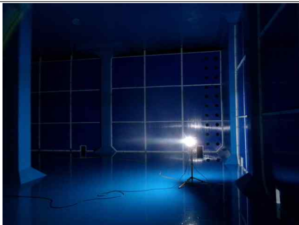
배수지 1지 내부 전경
