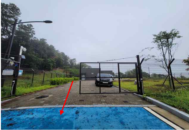
위 치 송수관로 (Sta.1+9.0) 손상내용 포장 및 지반 상태양호
