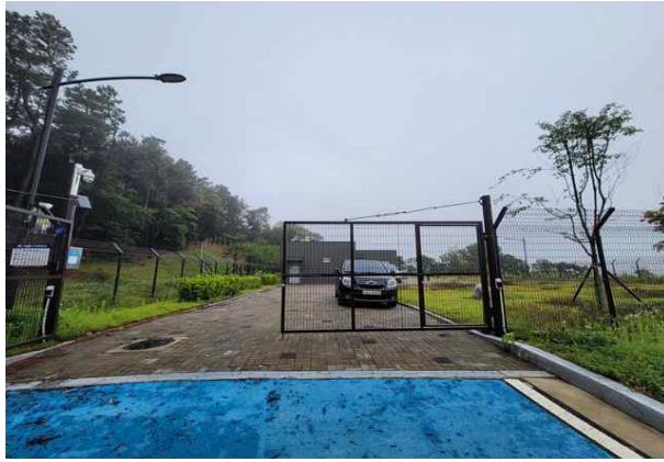
송수관로 시점부 전경
