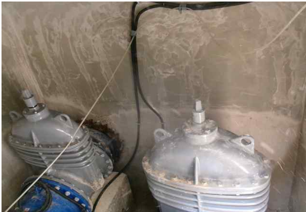
위 치 송수관로 Sta.4+0.0(유량계실) 손상내용 벽체 상태양호
