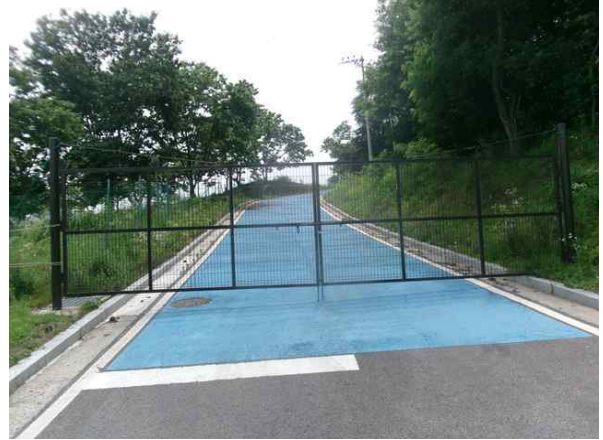
송수관로 종점부 전경
