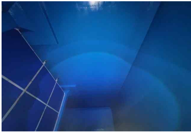
손상내용 2지 상부슬래브 상태양호 손상원인 -
