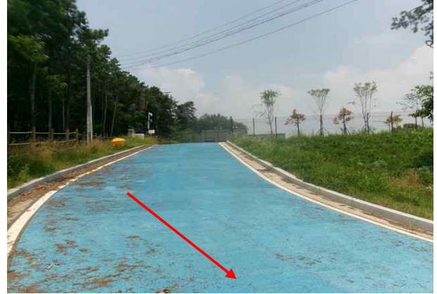
위 치 송수관로 (Sta.3+16.1) 손상내용 포장 및 지반 상태양호
