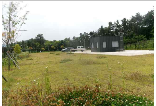
배수지 상부 현황
