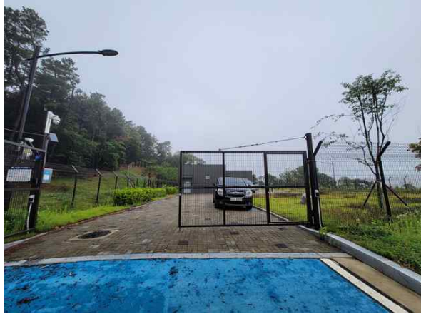
송수관로 시점부 전경
