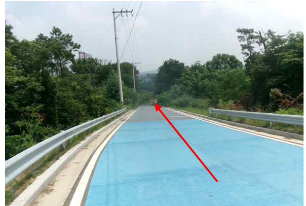
위 치 송수관로 (Sta.7+16.7) 손상내용 포장 및 지반 상태양호
