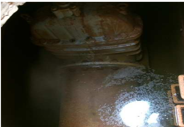
위 치 송수관로 Sta.17+1.5(점검구) 손상내용 도장 상태양호
